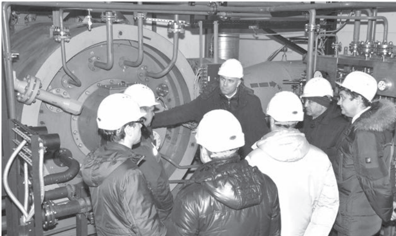
Генеральный директор ООО «Газпром трансгаз Чайковский» Сергей Сусликов в одном из компрессорных цехов Воткинского ЛПУМГ
